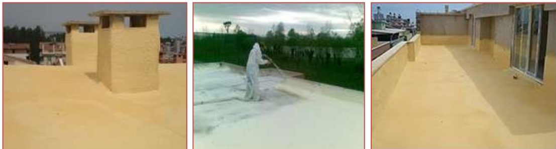
Fot. 2÷4 Metoda natryskowa docieplenia stropodachów pełnych
