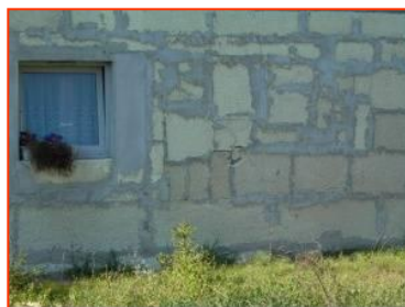
Fot. 11÷12 Przykłady nieprofesjonalnego wykonawstwa docieplenia
