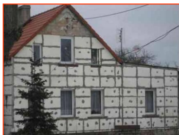
Fot. 11÷12 Przykłady nieprofesjonalnego wykonawstwa docieplenia
