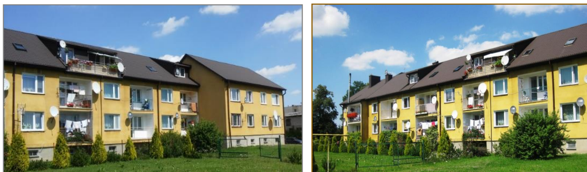
Rys.4. Ogólny widok domów przed modernizacją. Źródło: T. Żurek – IMP PAN Gdańsk
